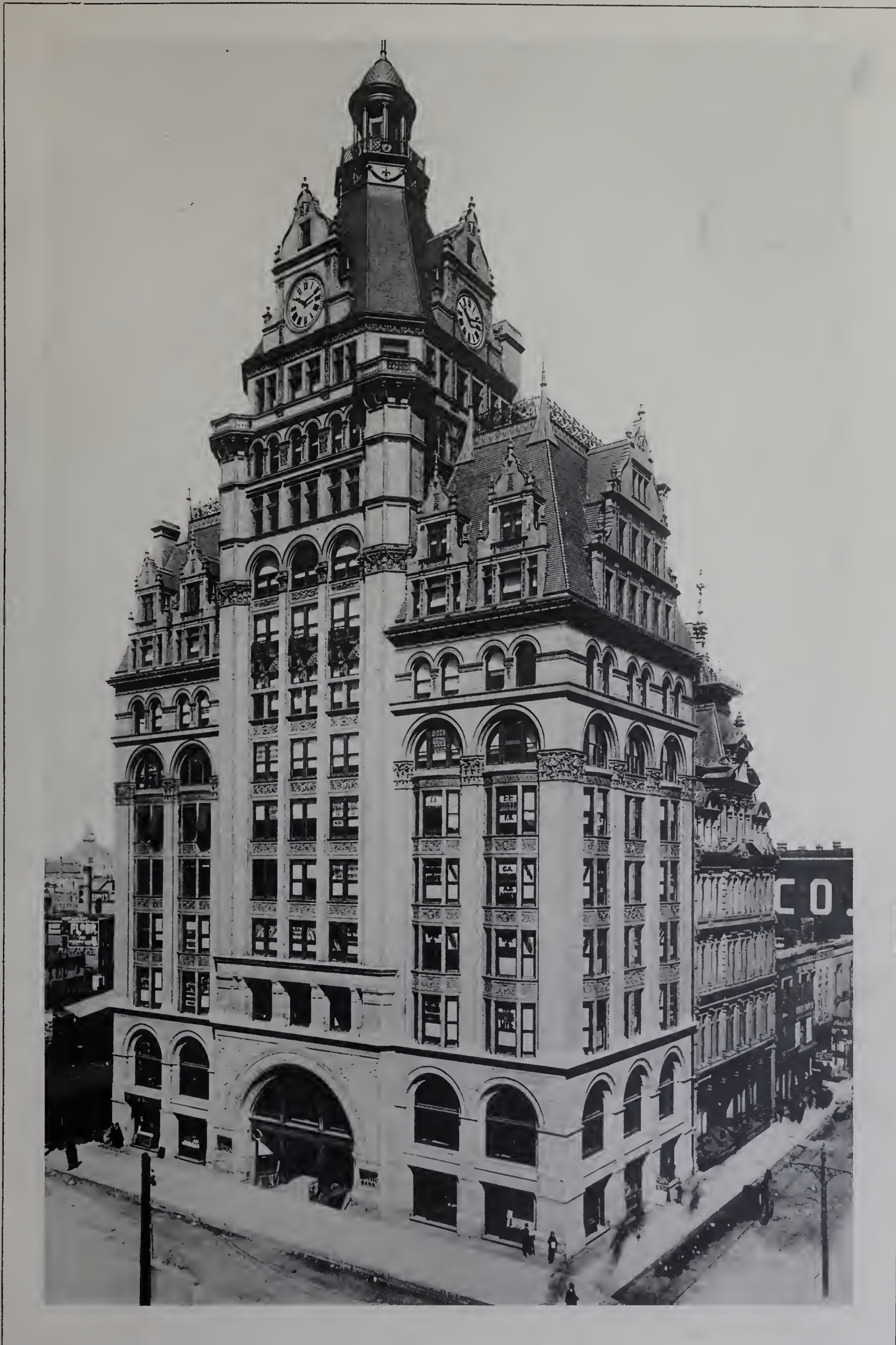
Architekt: S. S. Beman, Chicago.
